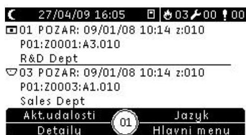
Obrázek 4: Indikace požárního poplachu na obrazovce ústředny
